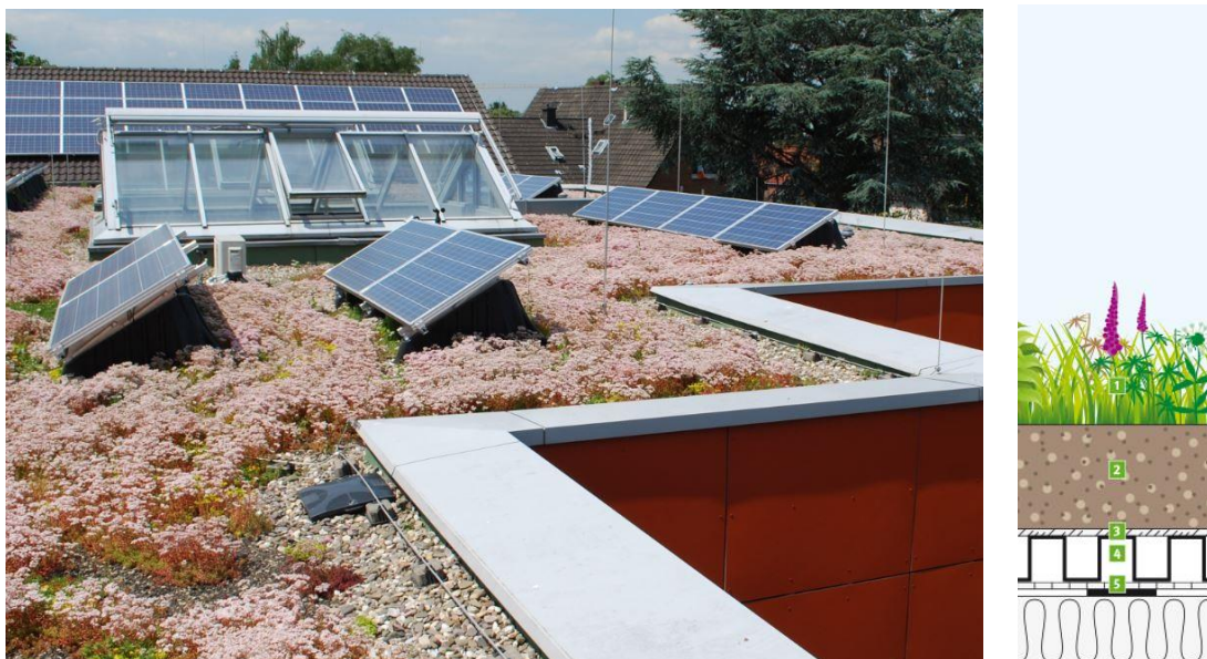
Obrázok 5 - osadenie FV panelov na zelenej streche
