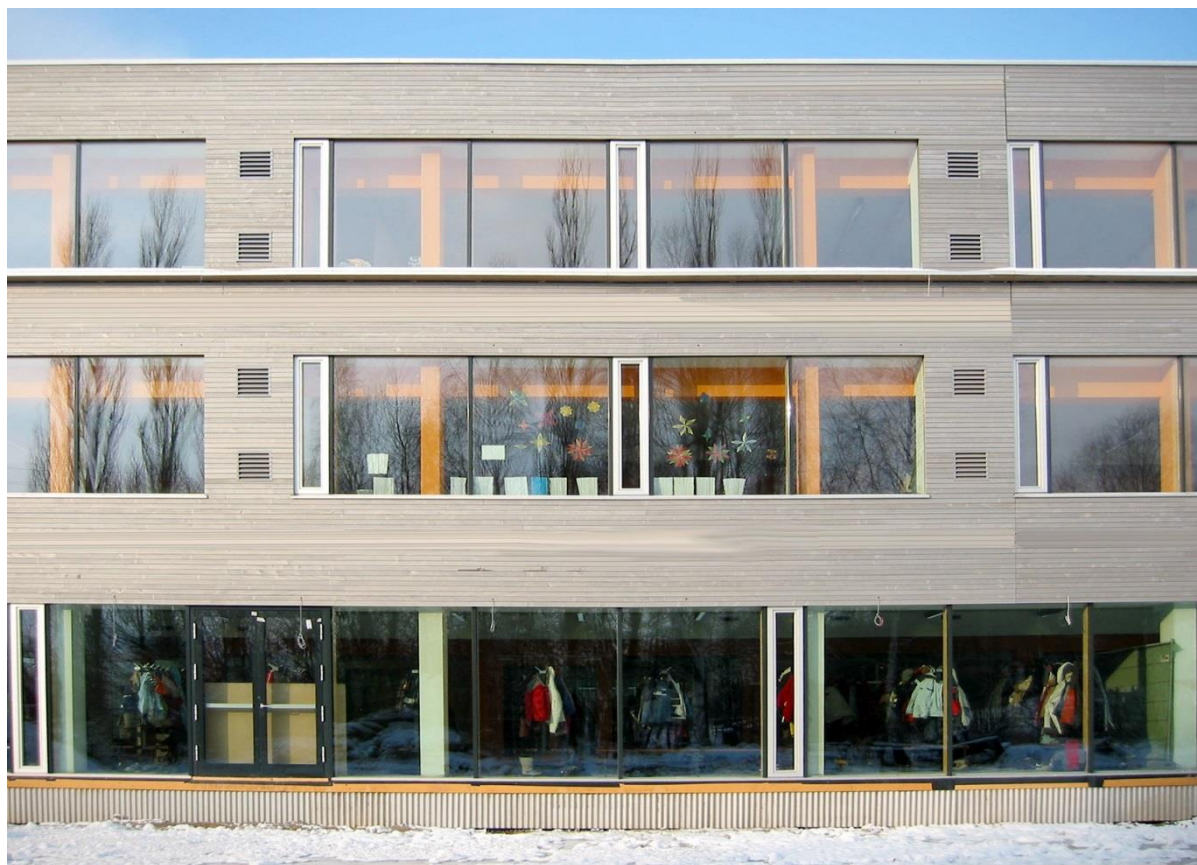
Obrázok 10 - Použitie dreva vo fasáde a otváracích krídel a
