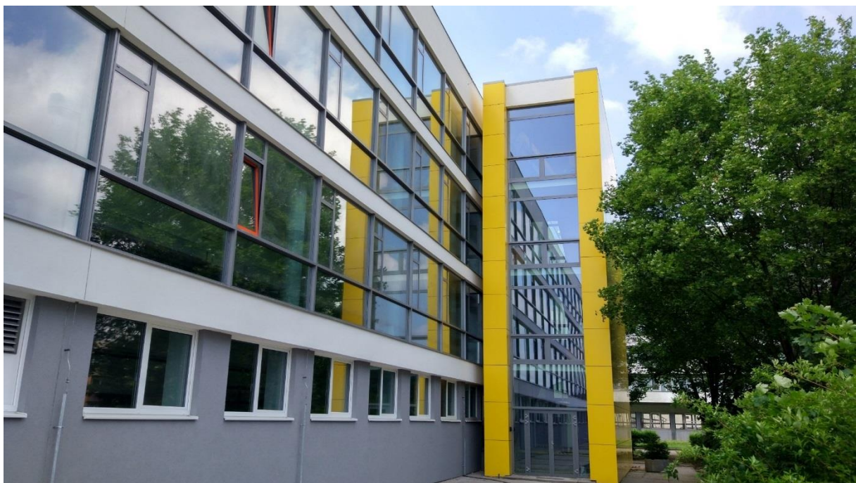
Obrázok 7 -Design kombinácie Kontaktnej fasády a odvetranej skladanej fasády s bonodového materiálu
