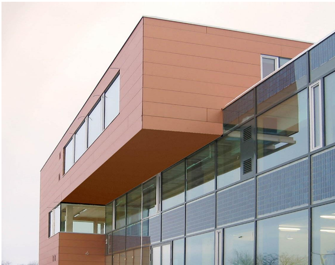
Obrázok 13 - tienenie presahom fasády a integrácia PV
