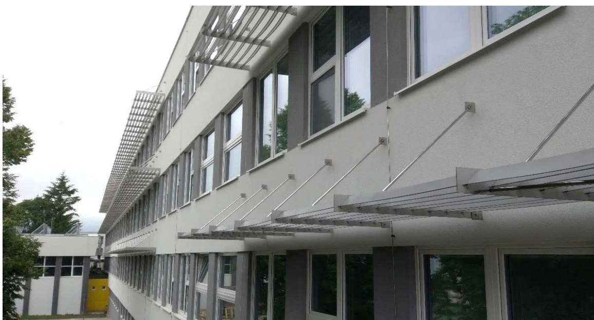
Obrázok 12 - tienenie južnej fasády horizontálnymi slnolamami
