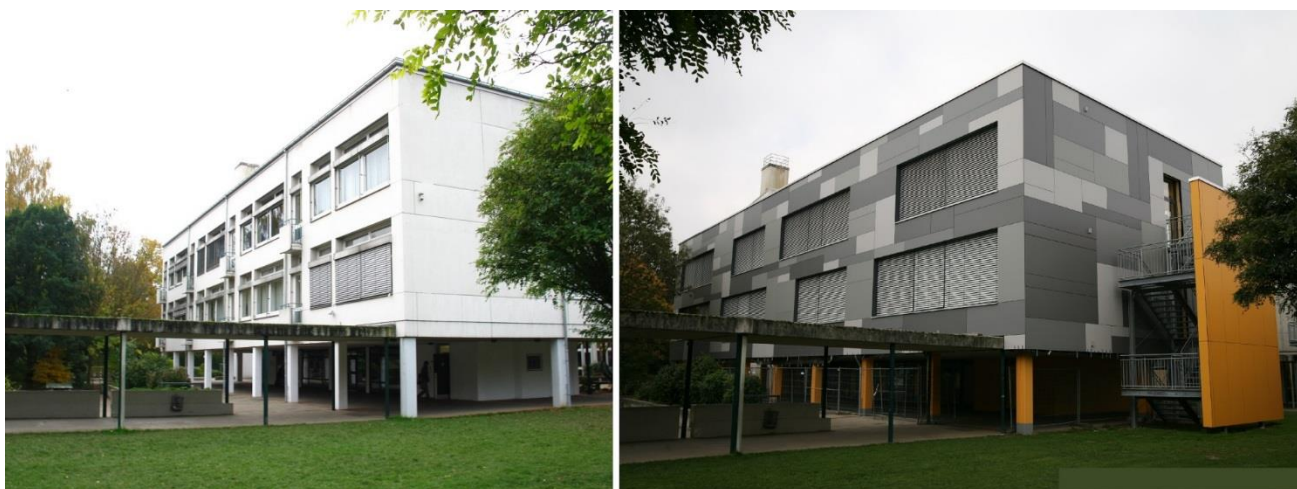
Obrázok 9 - kombinácia kontaktnej a odvetranej fasády
