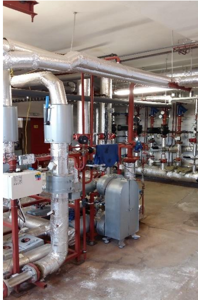
Obrázok 3: Zdroj tepla pre ZŠ – tlakovo nezávislá DOST BAT, a.s.
