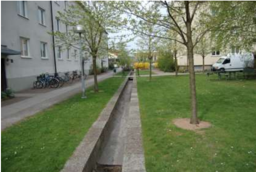
Foto 15: Otvoreným zvodom dažďovej vody sa táto vedie vodného prvku autorka fotografie Zuzana Hudeková
