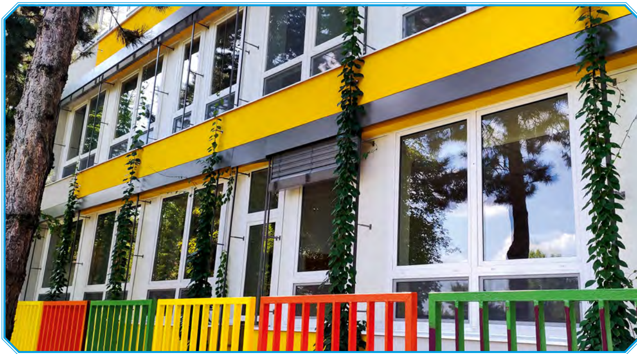
Obr. č. 15: MŠ Kolískova 14: tri vegetačné steny z nerezovej lankovej siete s popínavými rastlinami a pätnásť vertikálnych lankových systémov s ovíjajúcimi rastlinami (zdroj: archív MČ Bratislava-Karlova Ves)
