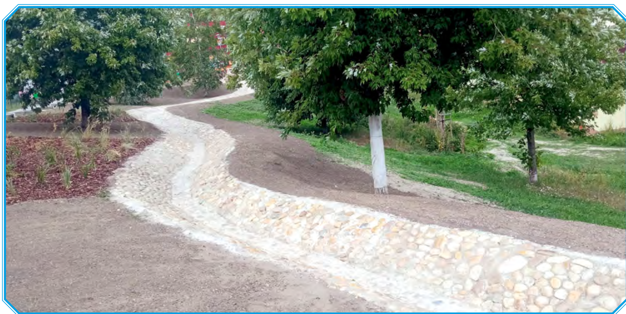
Obr. 26: 3.Etapa – výstavba umelého potôčika, využívajúceho zrážkovú vodu (zdroj: archív MČ Bratislava-Karlova Ves)
