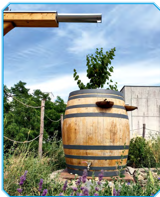
Obr. č.4: Altánok pre potreby exteriérovej eko-učebne pri školskej záhradke v športovo-rekreačnom areáli Majerníkova 60-62, Bratislava-Karlova Ves. Zachytávanie zrážkovej vody do nádrže zo strechy altánku a jej využívanie na polievanie ovocných kríkov a bylínok v rámci ekovýchovných aktivít. Prepad z nádrže v hornej časti slúži ako napájadlo pre vtáctvo a hmyz (zdroj: archív MČ Bratislava-Karlova Ves)
