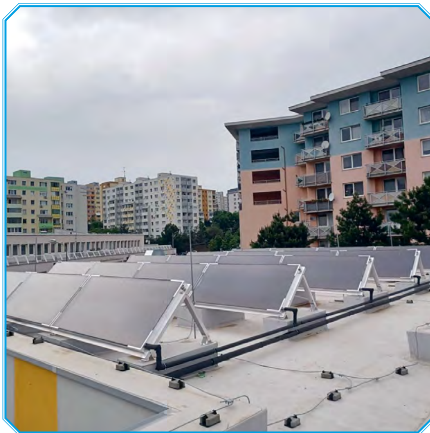
Obr. č. 18 a č. 19: Zásobníky na teplú vodu zohriatu cez fototermitické panely (zdroj: archív MČ Bratislava-Karlova Ves)
