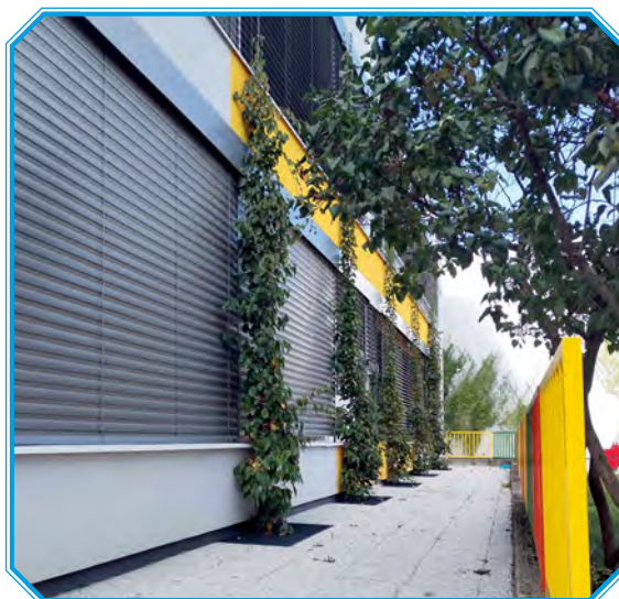
Obr. č.31c: MŠ Kolískova 14: tri vegetačné steny z nerezovej lankovej siete s popínavými rastlinami a pätnásť vertikálnych lankových systémov s ovíjavými rastlinami (zdroj: archív MČ Bratislava-Karlova Ves)
