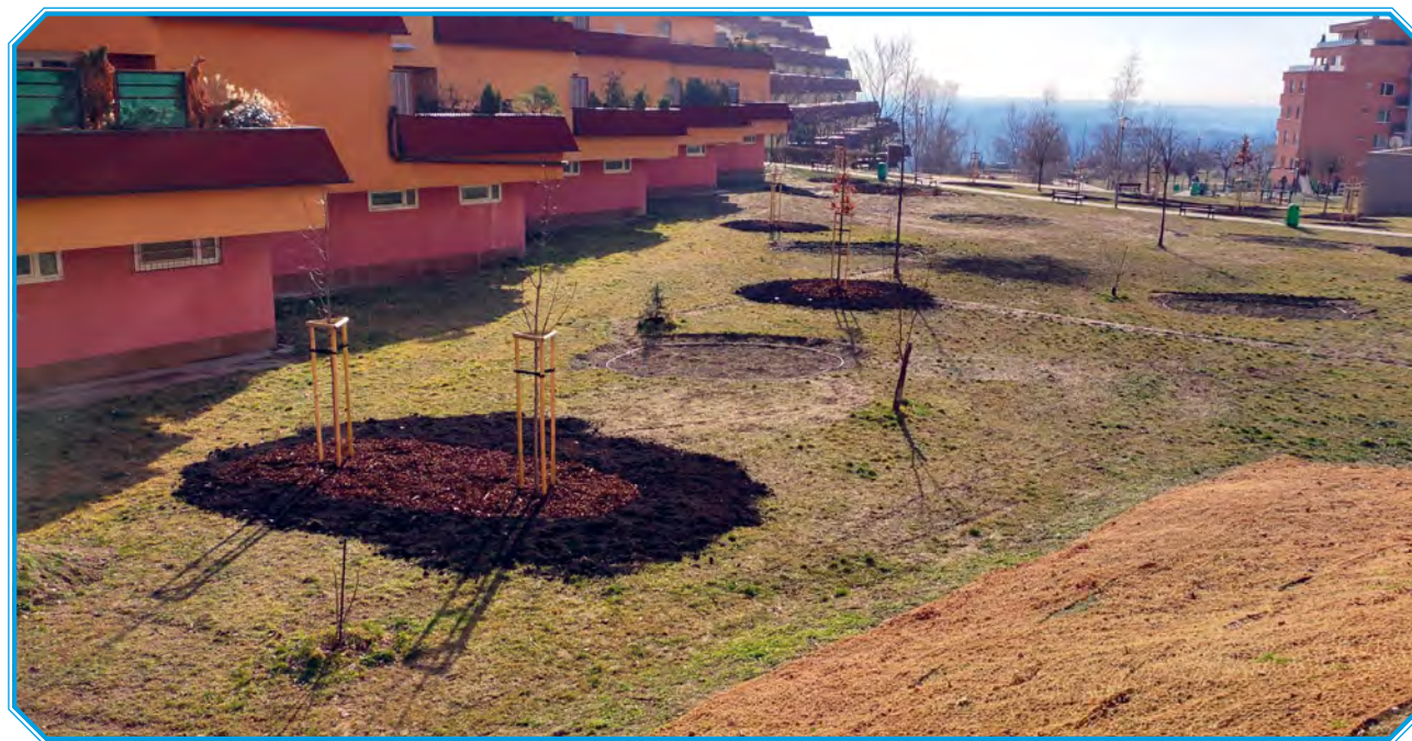
Obr. č.21: Terénne modelácie, výsadba stromov so závlahou zo zachytenej vody, retenčné miskové plochy s vysadenou lúčnou zmesou (zdroj: archív MČ Bratislava-Karlova Ves)
