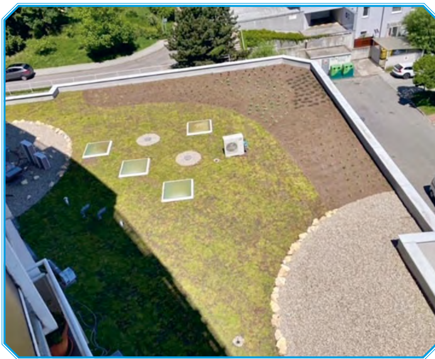
Obr. č. 8: Pohľad zhora na vegetačnú strechu po realizácii (zdroj: archív MČ Bratislava-Karlova Ves)
